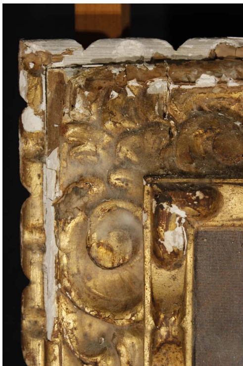
Figura 21. Detalle de la orna- mentación dorada en una enmarcación, con oxidación y pérdidas puntuales de lámi- na de oro y preparación.
