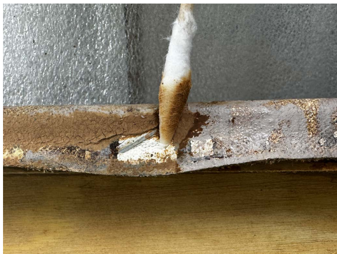
Figura 29a. Proceso de limpieza del reverso por humedad controlada.
