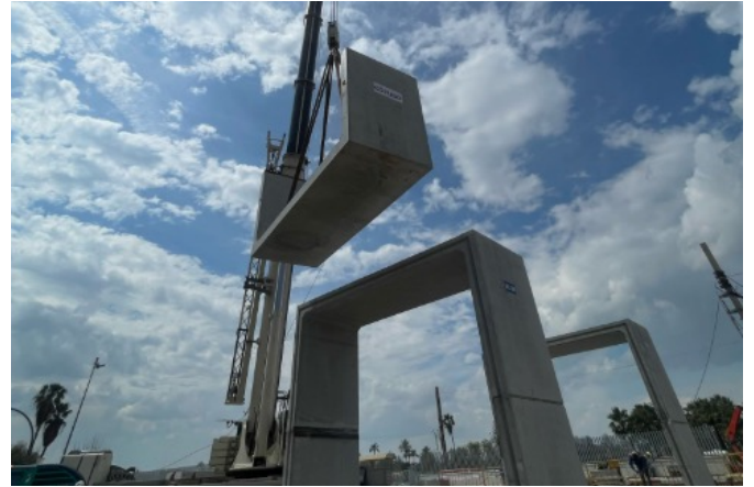
Figura 40b. Montaje de los módulos prefabricados.
