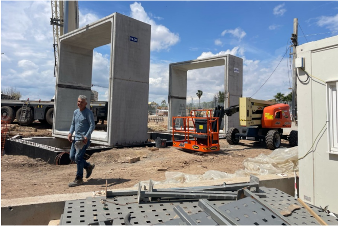
Figura 40a. Montaje de los módulos prefabricados.
