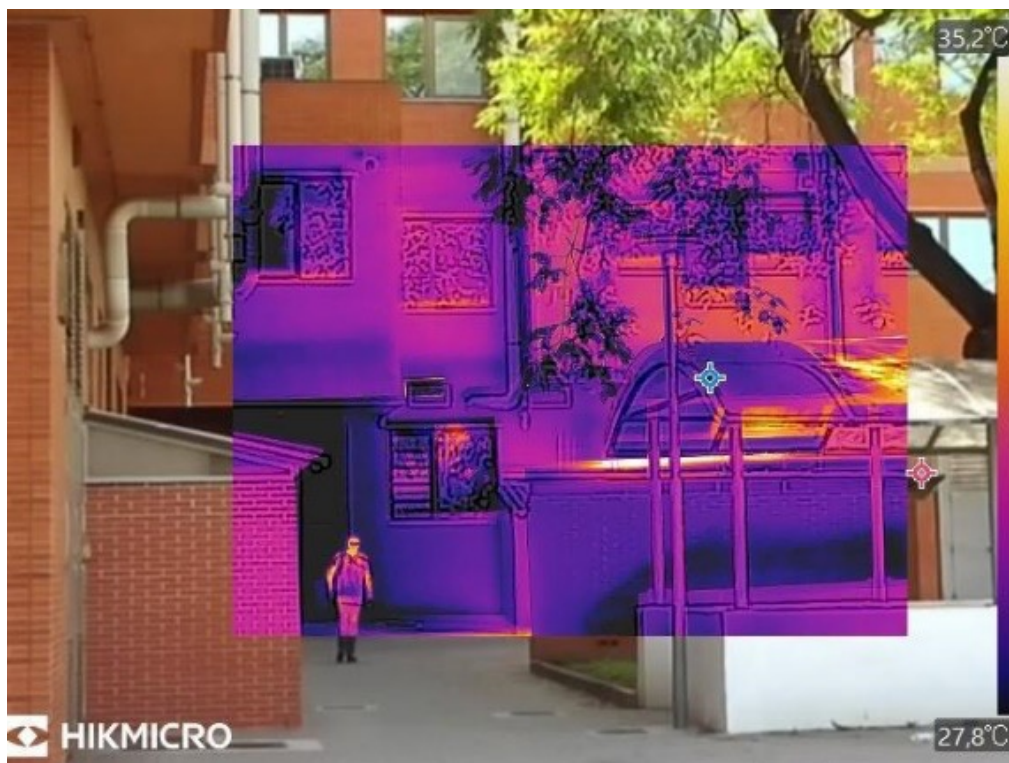
Figuras 21. Superposición de información visible y térmica en la inspección de una fachada.
