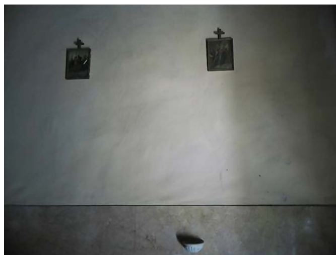
Figura 31b. Información térmica en la Iglesia de Sant Jaume en Algemés. Autor: Juan Miguel de la Fuente Larrain.
