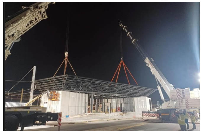
Figura 41. Montaje de la estructura metálica de la cubierta.
