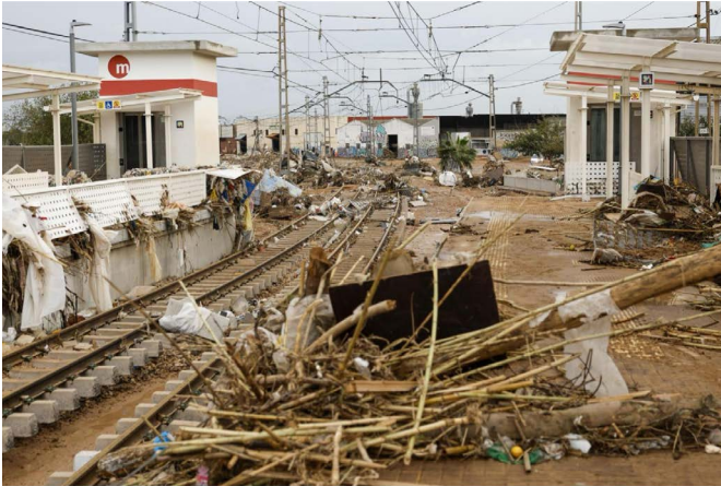
Figura 36. Estado de la estación de metro de Paiporta después de la catástrofe provocada por la DANA.
